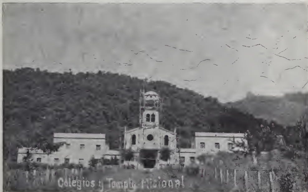
Abajo: Vista del frente del mismo Centro.
